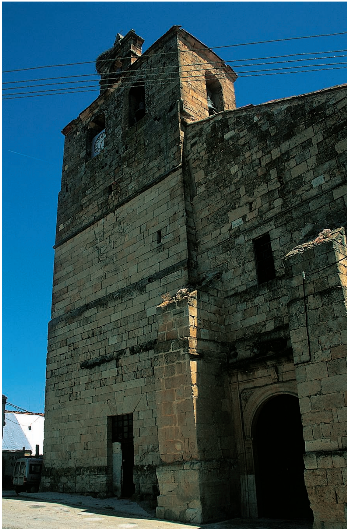
Hastial de occidente y torre, donde se conservan algunos de los restos más antiguos
