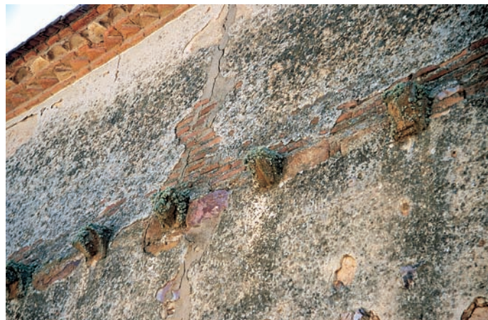
Canchillos del muro norte
