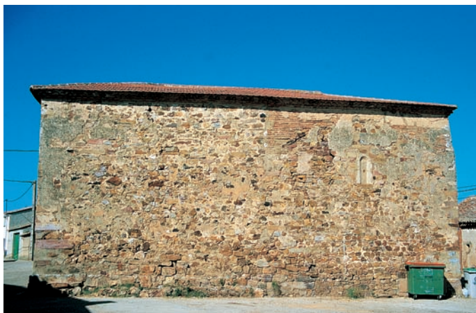
Muro oriental de la cabecera
