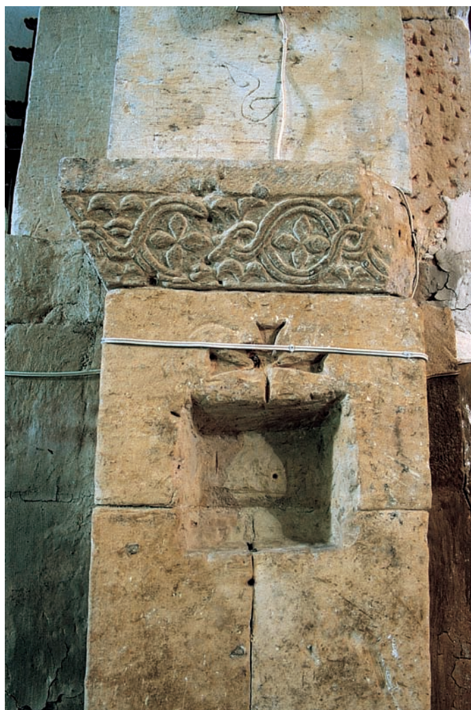
Pilar de la nave
