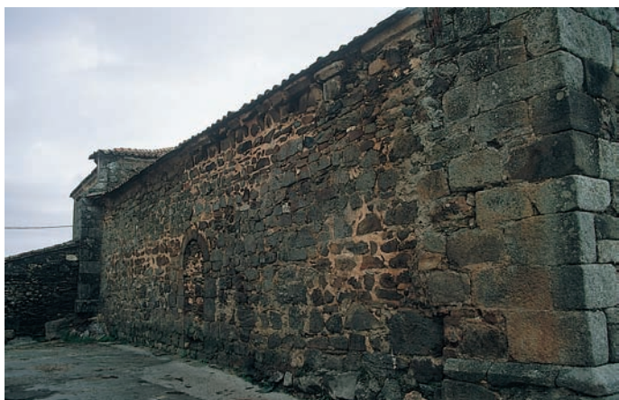
Muro norte de la nave, que incluye una portada cegada
