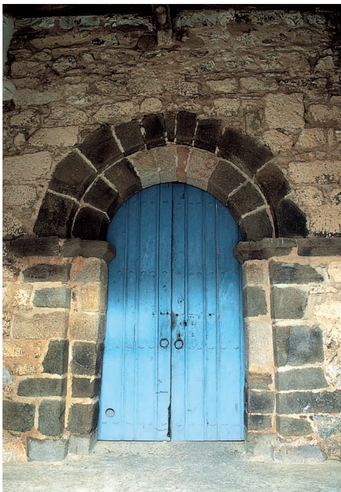
Portada en el muro sur
