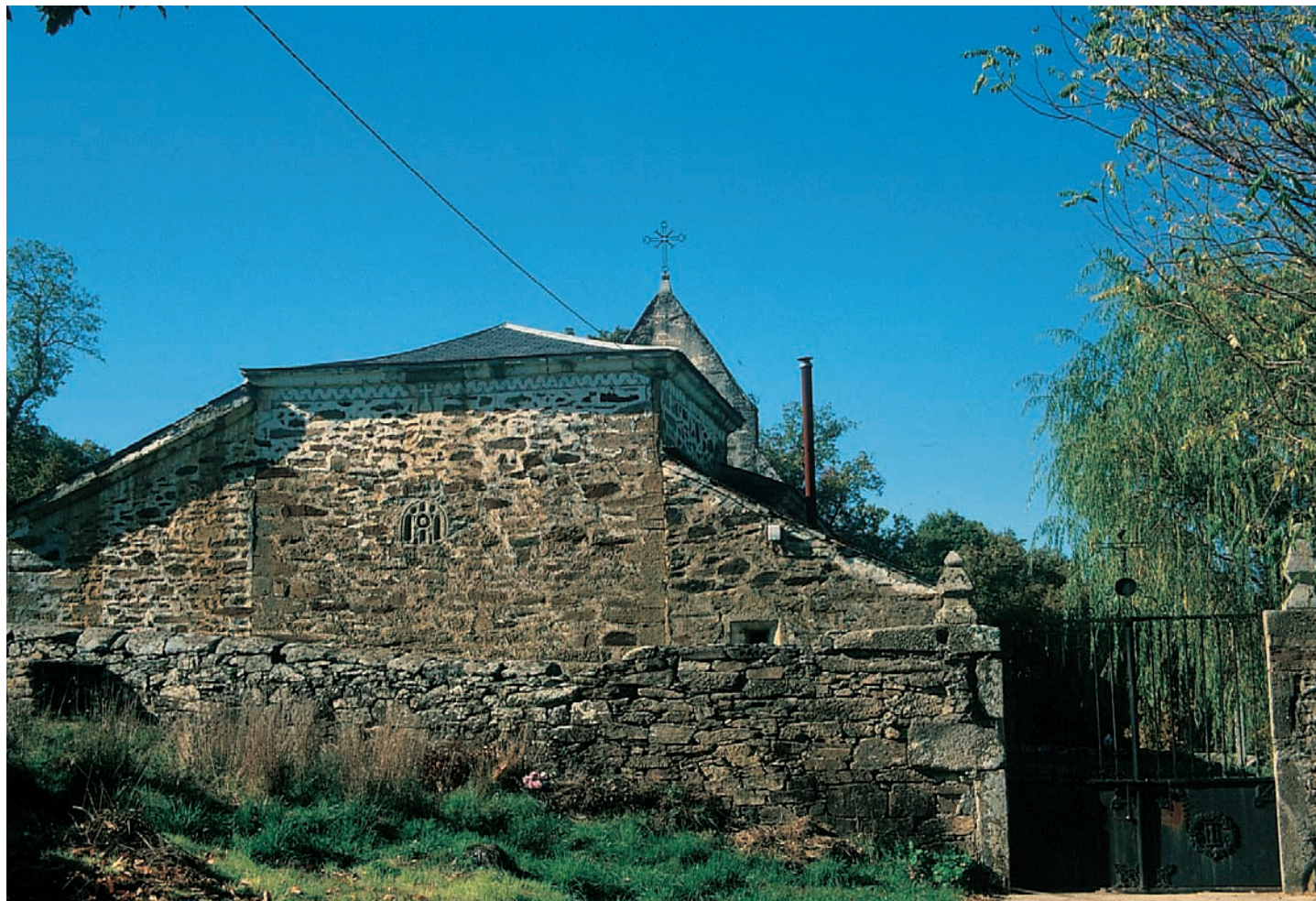
Exterior de la cabecera de San Mamés
