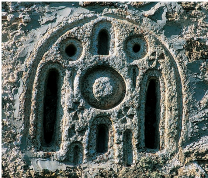
Celosía en la cabecera
