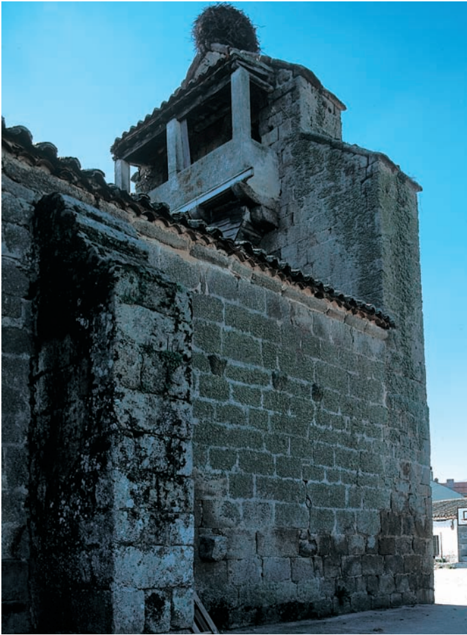
Restos de la fábrica románica en el muro norte
