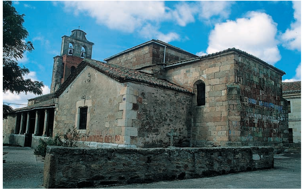
Aspecto que presenta la iglesia en la actualidad
