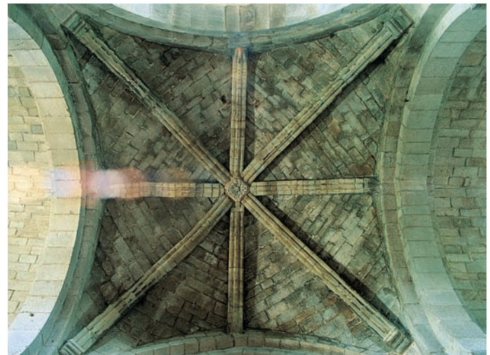
Bóveda del crucero
