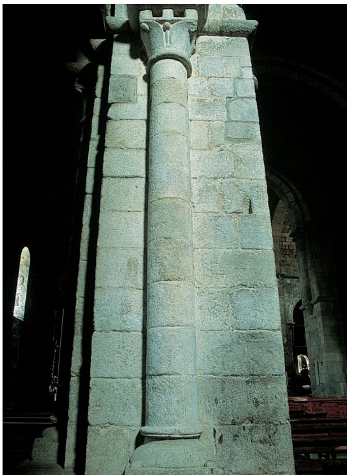
Pilar de la nave
