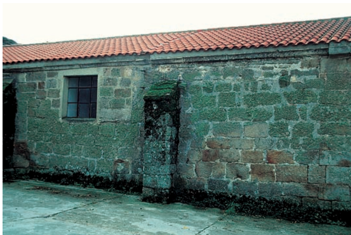
Posible paramento románico, con canecillos, en el muro norte
