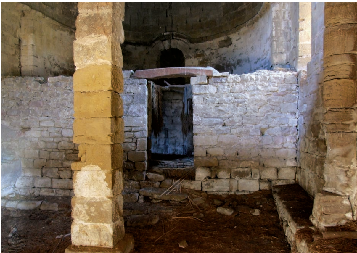
Interior hacia la cabecera
