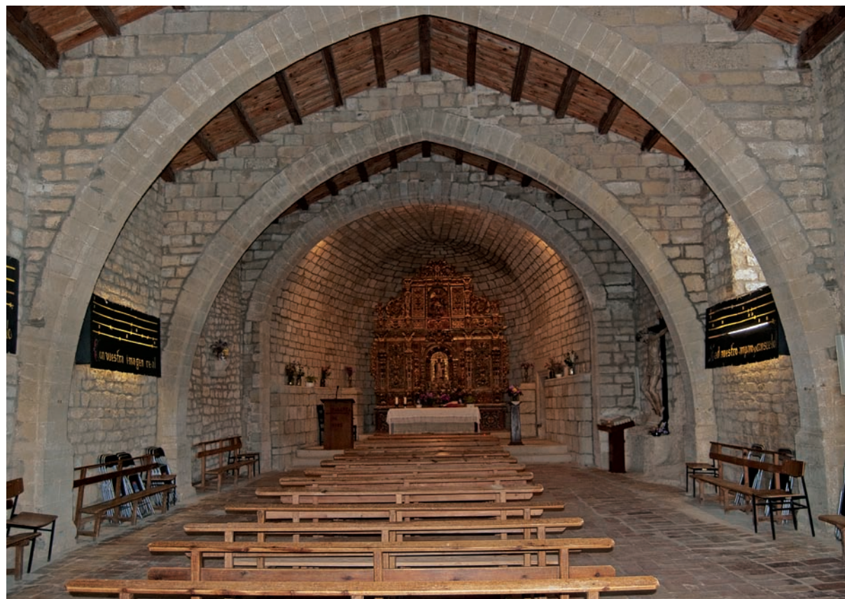
Interior de la nave
