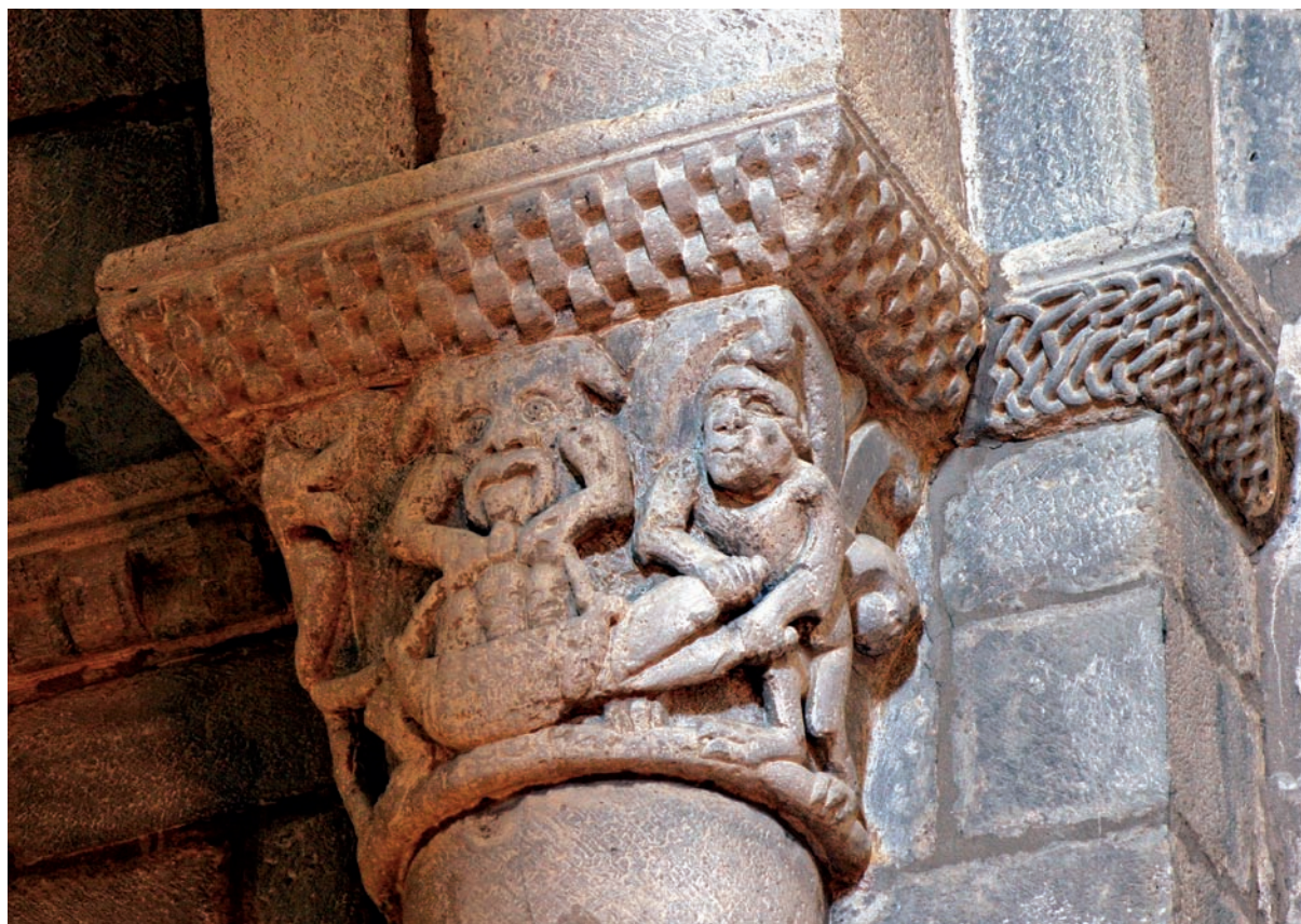
Iglesia alta. Capitel de los pilares de la cabecera
