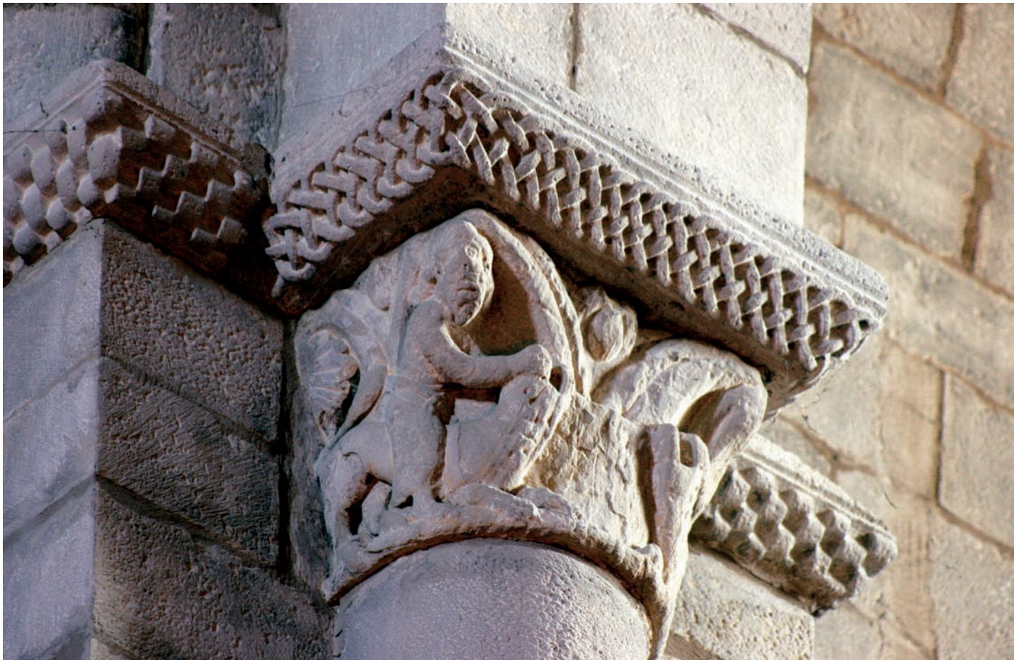
Iglesia alta. Capitel de los pilares de la cabecera
