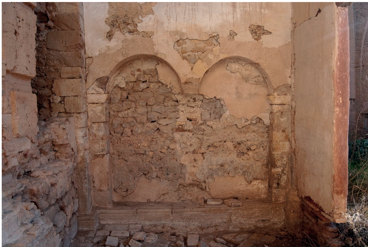
Arquería de la capilla central
